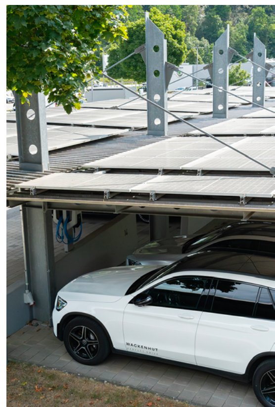
Zdjęcie przedstawi a bliższy widok modułów fotowoltaicznych, na które mają wpływ cienie strukturalne
